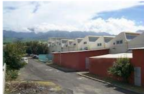
Toits de Shed
